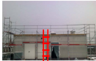
Positionnement de l'échelle avant la mise en place de l'échafaudage périphérique
